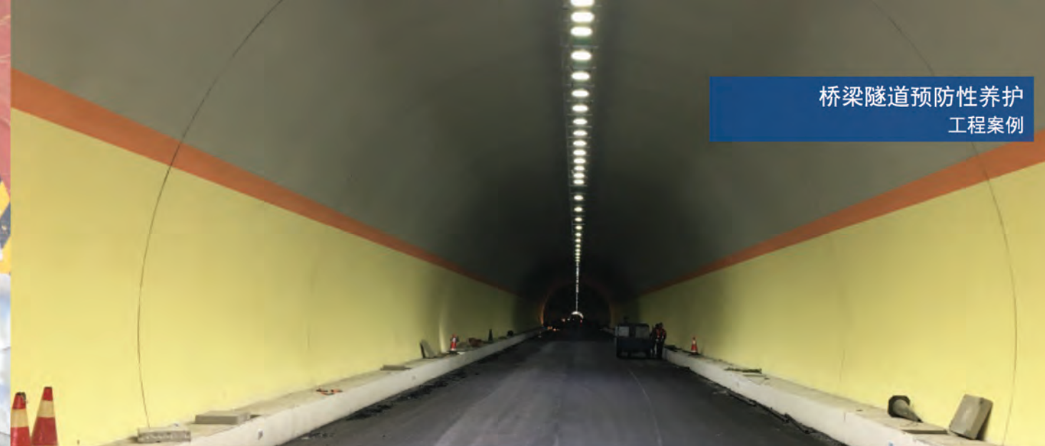
G312线（静宁隧道）
