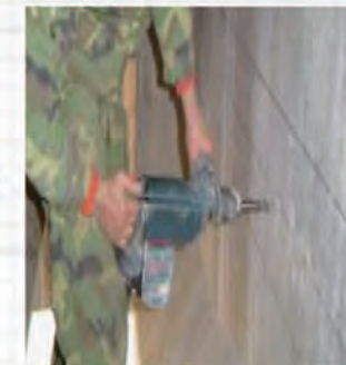
钻孔 FH-G8073 电机可以快速钻孔。钻孔应当清理干净，保持干燥，不得有油污。
