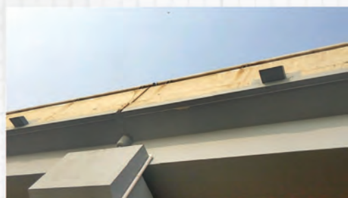
梁侧及排水管、泄水孔施工前后对比照片
