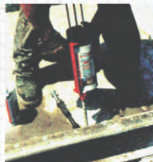
注 胶 FH-E131 快干型化学植筋胶 两分钟初凝；无需调和；使用快捷方便。
