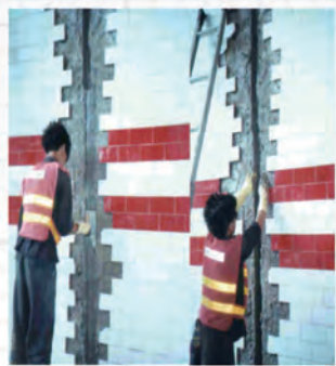
渗水处基面（裂缝、施工缝）进行表面处理
