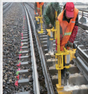
快速钻孔和清孔 FH-G8073 轨枕钻孔机(电动) 专用的二型轨枕垂直定位钻孔机可以快速对位、快速钻孔、快速下道
