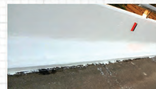
伸缩缝施工前后对比照片
