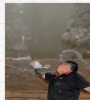
根据脱落部位及缺陷程度，进行不同批 次的修复。
