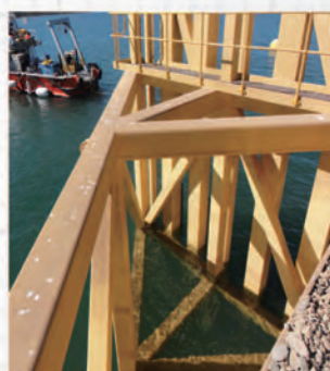
待FH-CX成膜后，进行底涂施工（厚约 50μm） 待底涂涂表干后，进行第一道面涂施工 （厚约100μm） 进行第二道面涂施工（厚约100μm）
