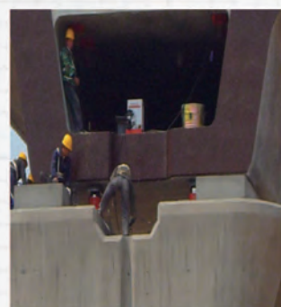
根据原桥梁设计结构 特点确定起顶点
