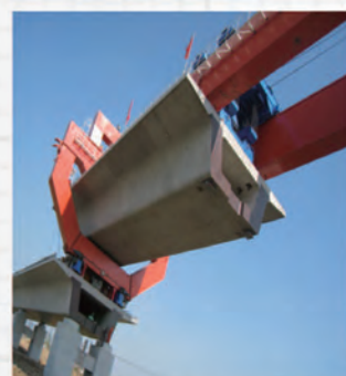
正式起顶作业
