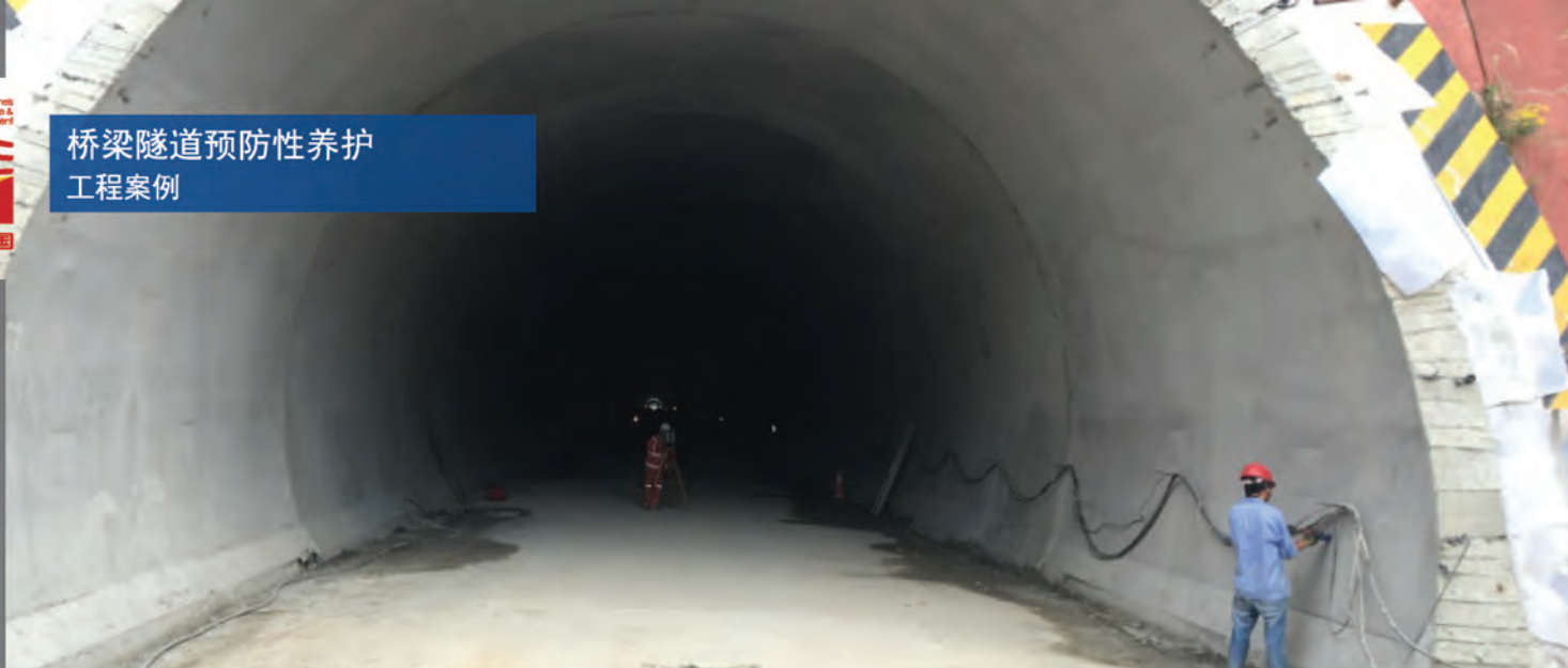
G312线（静宁隧道）
