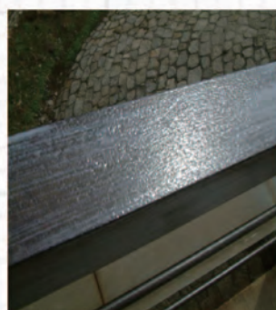
待钢筋表面水干后，对钢筋表面涂 刷第一道FH-CX锈转化剂有漏涂的部位 ，涂刷第二道锈转化剂 完全彻底转化铁锈成膜，无残锈存 在。分子级的重排成膜紧密覆盖钢铁表面， 涂膜封闭性好，完全阻隔空气及水份。 水性单剂型，不需溶剂即可施工。
