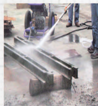
高压水射流表面除锈处理 对防护栏杆杆进行表面处理。
