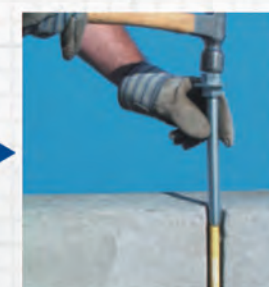
钻孔和清孔 快速植入 敲击式化学锚栓
