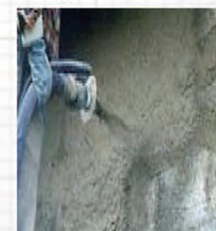
桥梁加固 解决桥梁隧道修补加固中压浆、修补、喷涂、远距离输送等一系列问题，使用时只需额外配一台发电机。
