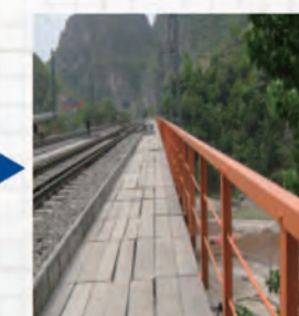
桥梁人行道增设
