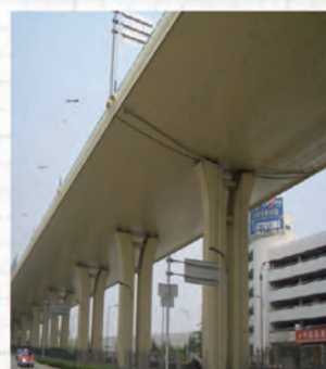
恢复公(铁)路运行
