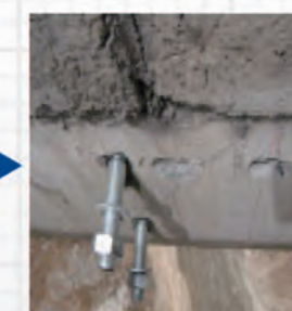
桥梁人行道U型 螺栓断裂改造
