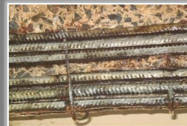
梁体、墩台、墩帽：清除松动混凝土、钢筋除锈、大面积清洗
