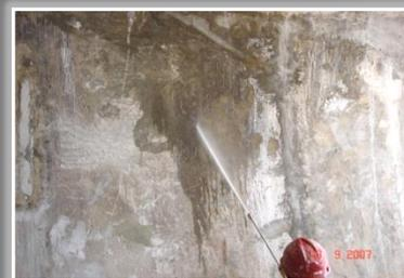
日常检查预处理：大面积清洗、露出混凝土原有基面
