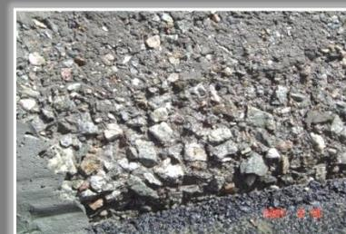
梁体、支座、墩台：清理灰尘、浮渣、油污、油渍、混凝土打毛
