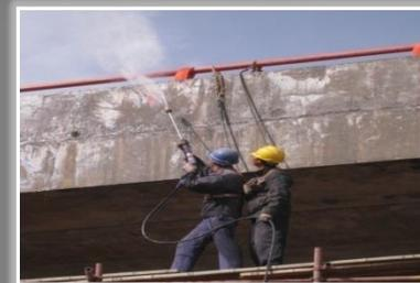
日常检查预处理：大面积清洗、露出混凝土原有基面
