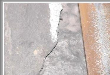
拱侧、拱顶：清理渗水结晶、剥落掉块、灰尘、浮渣、油污、油渍
