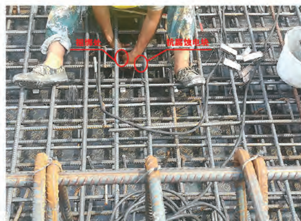
抗腐蚀电块捆绑图
