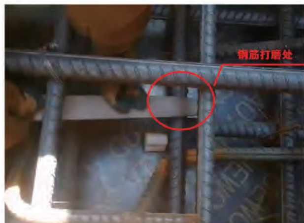
打磨钢筋，去除阻锈漆
