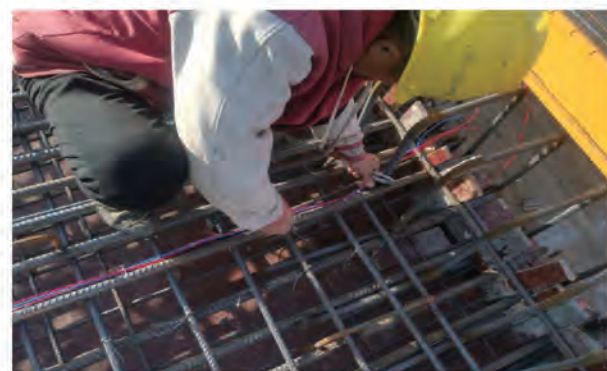
无抗腐蚀电块区域钢筋锈蚀监测引出线连接
