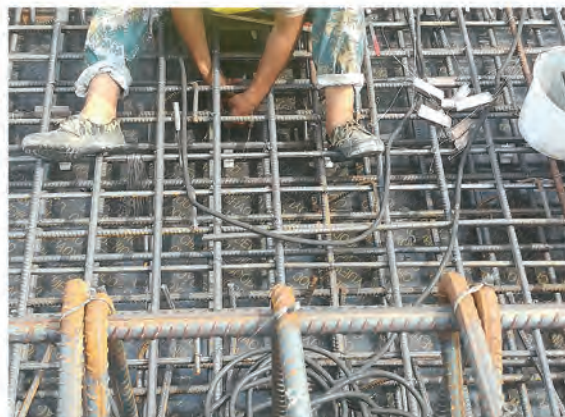
1. 根据图纸安装抗腐蚀电块
