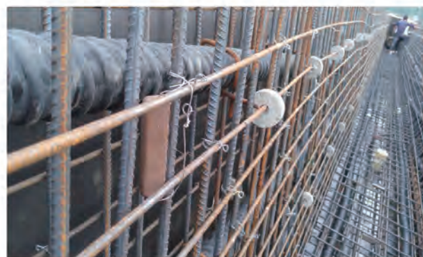
箱梁腹板及锚头安装抗腐蚀电块
