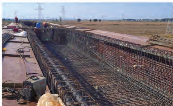
安装完成抗腐蚀电块后的梁体
