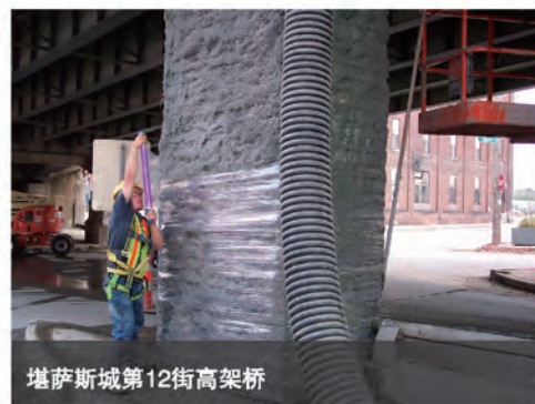
阳极系统的安装——桥梁下部结构
