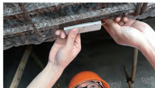
梁底安装抗腐蚀电块
