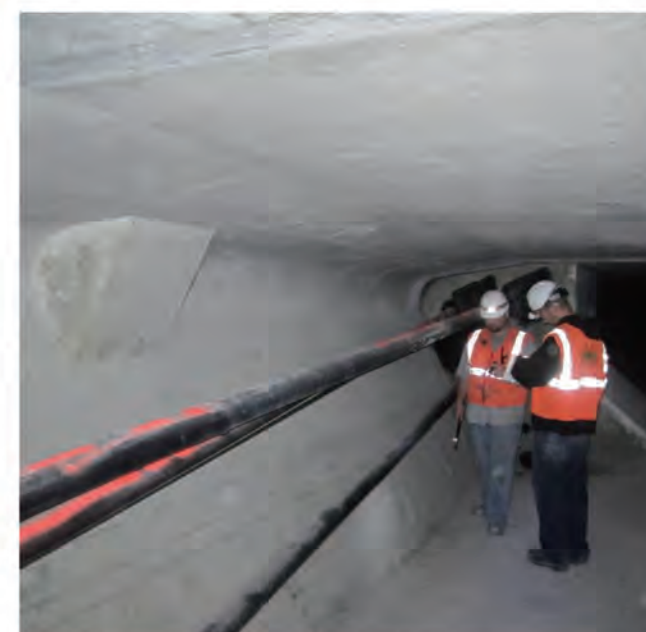
新旧灌浆料会让钢绞线之间形成电位差,导致加速旧浆料中的钢绞线加速腐蚀
