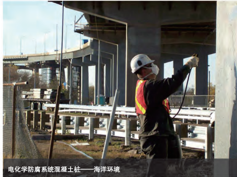
阳极系统的安装——桥梁下部结构
