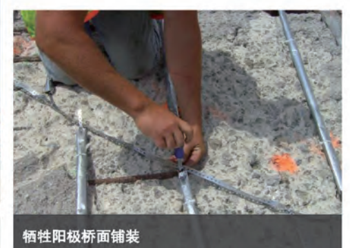
牺牲阳极桥面铺装
