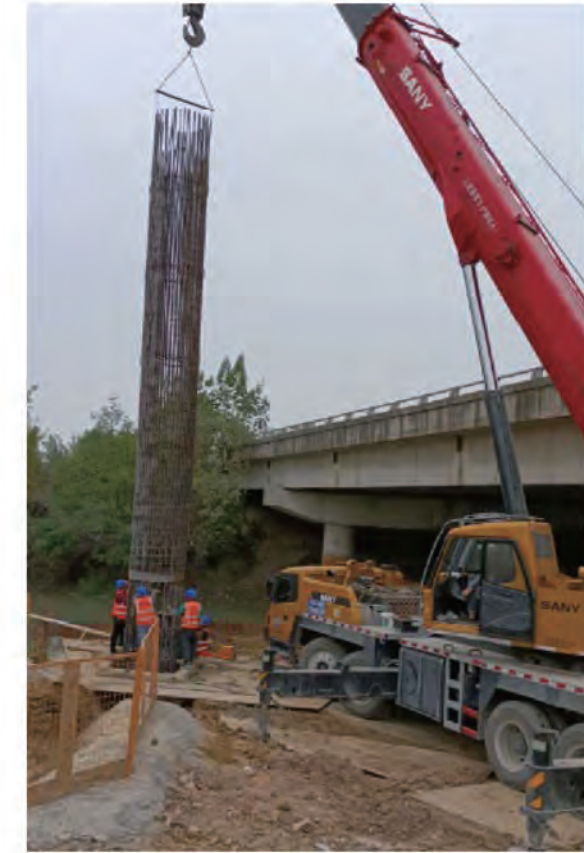
吊装钢筋笼至预定位置
