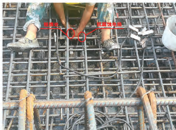
抗腐蚀电块捆绑图
