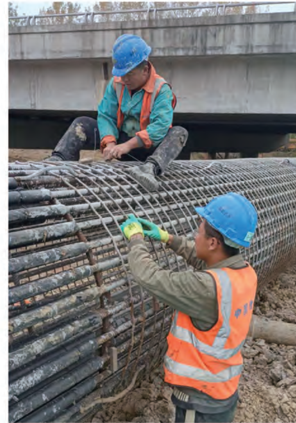
安装及检测抗腐蚀电块
