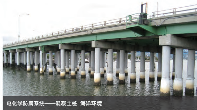
带电流保护的桥台修复
