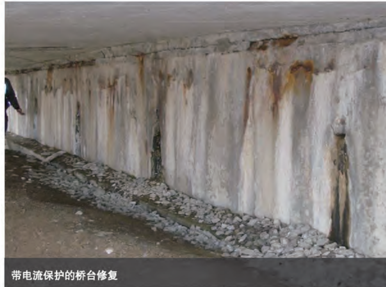
带电流保护的桥台修复
