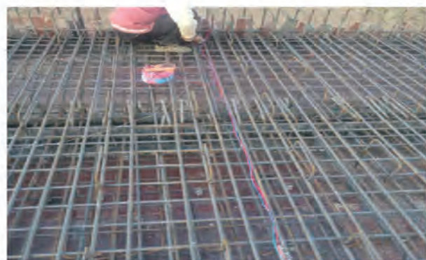
抗腐蚀电块安装检测及监测引出线连接
