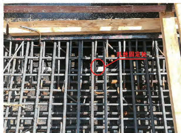
抗腐蚀电块固定图
