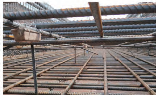
箱梁底板安装抗腐蚀电块
