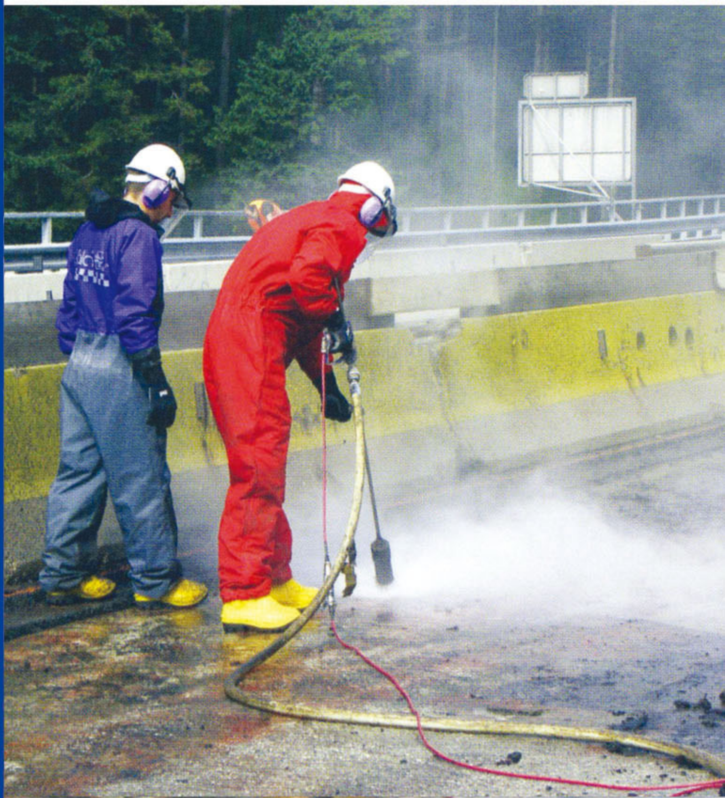
根据需求调节水转速， 对混凝土不同深度拉毛
