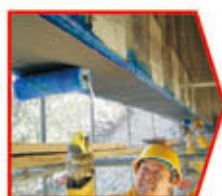
维修加固工程
