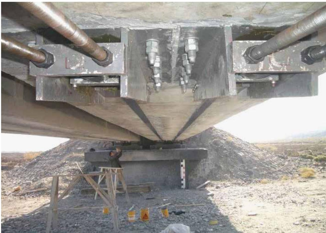
本工法主要为如何使用碳纤维复合纤维板对桥梁进行预应力后张拉维修加固的方案。
