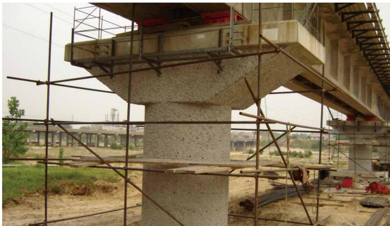
本工法主要解决为增加铁路桥梁横向刚度施工中如何对梁体进行钢筋探测、钻孔、植筋以及新旧混凝土结合面凿毛的问题。
